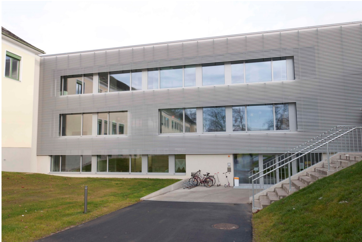
Mustersanierung des Schulzentrums in Kirchberg am Wagram
